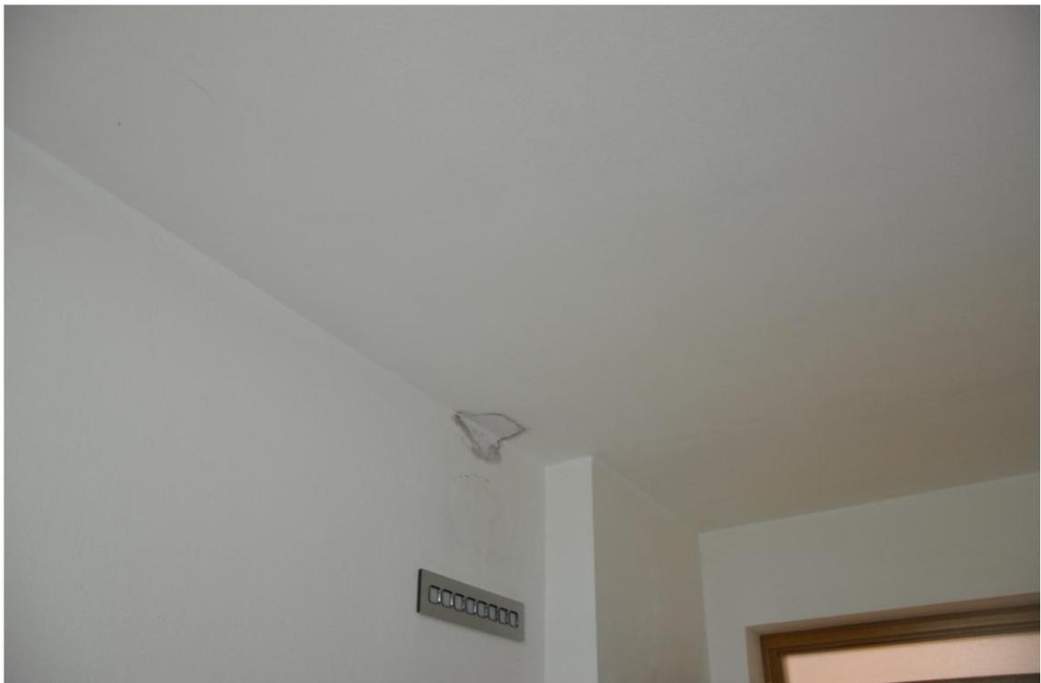
Infiltrazioni in corrispondenza delle tubazioni delle aerazioni forzate
